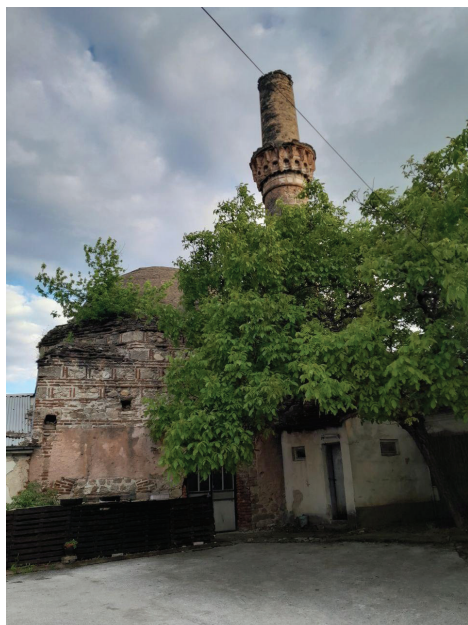
Слика 9. Скршена џамија, фото ДКШ, мај 2024 г.
